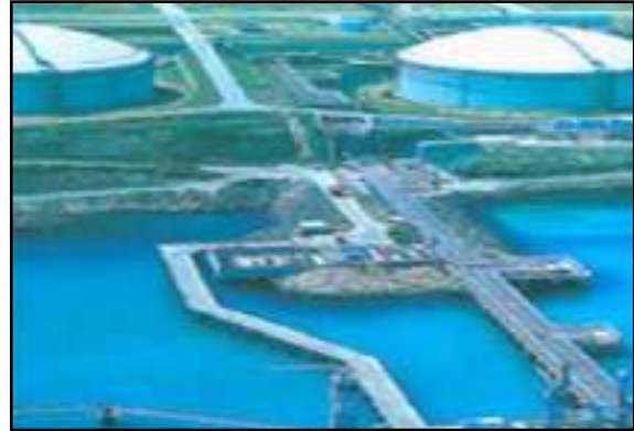
Figure 7. LNG import terminal of Marmara Ereğlisi.
